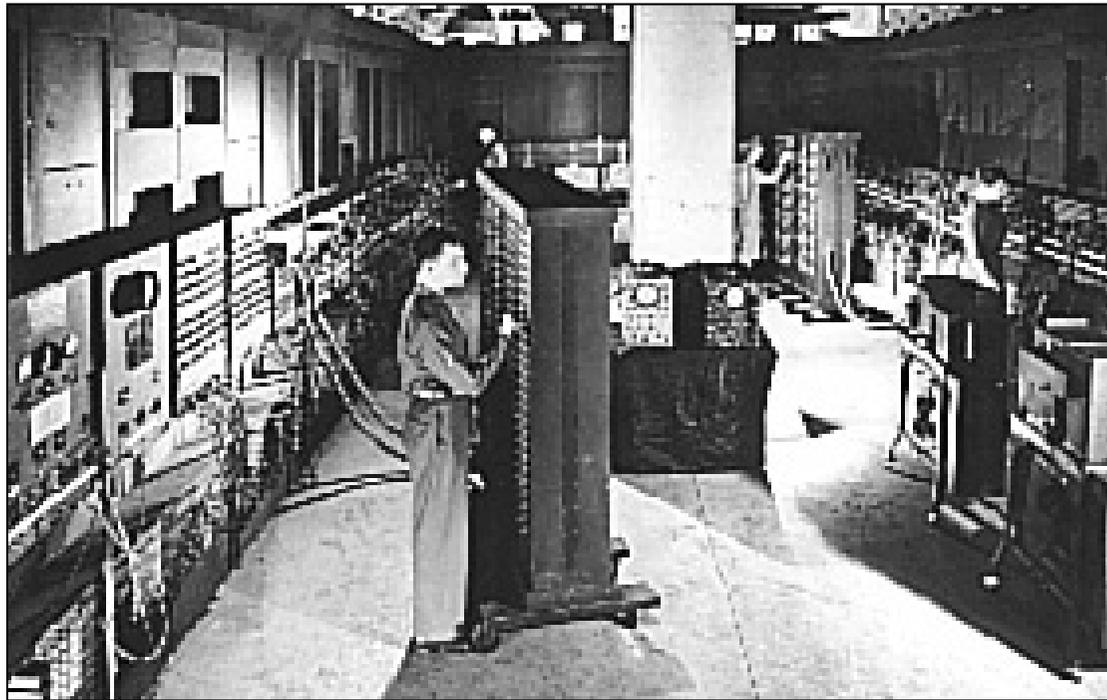
**1946:** ENIAC, 9x30 m<sup>2</sup>, 18000 valvole termoioniche, 1500 relè, 500.000 contatti, 174 kW potenza dissipata
